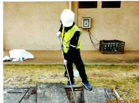
บ่อกักก่อนเข้าสู่ระบบบำบัดน้ำเสีย ของอาคารที่พักผู้โดยสาร ชุดที่ 2
