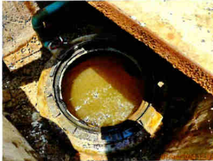
บ่อกักหลังผ่านระบบบำบัดน้ำเสีย ของอาคารที่พักผู้โดยสาร ชุดที่ 1
