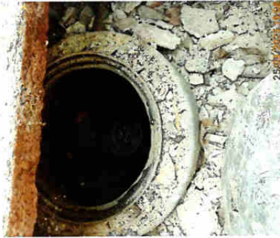
บ่อกักก่อนเข้าสู่ระบบบำบัดน้ำเสีย ของอาคารที่พักผู้โดยสาร ชุดที่ 1
