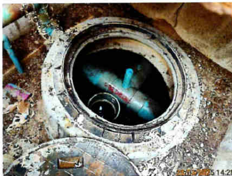
บ่อกักหลังผ่านระบบบำบัดน้ำเสีย ของอาคารที่พักผู้โดยสาร ชุดที่ 2
