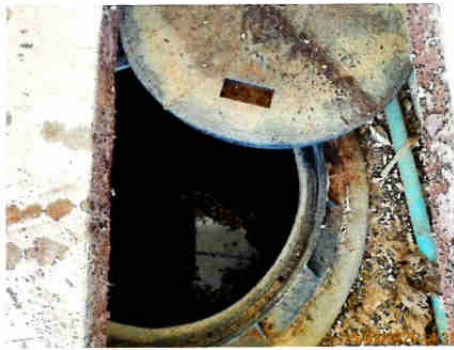
บ่อพักก่อนเข้าสู่ระบบบำบัดน้ำเสีย ของอาคารที่พักผู้โดยสาร ชุดที่ 3
